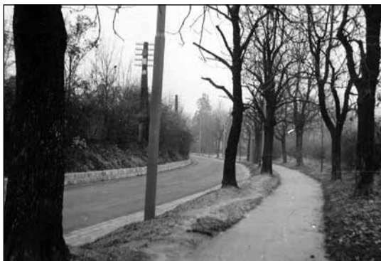
Auf dem linken Bild sieht man bereits den neuen Mast für die Neonbeleuchtung und auch noch eine alte Gaslaterne.
